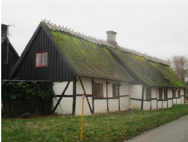
4. Bygning 1, Stuehus set fra nord øst. Vinter 2025.
